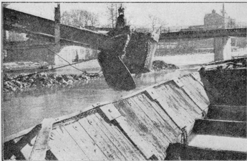
FIG. 31. — Chaland à clapets pour débris rocheux.
