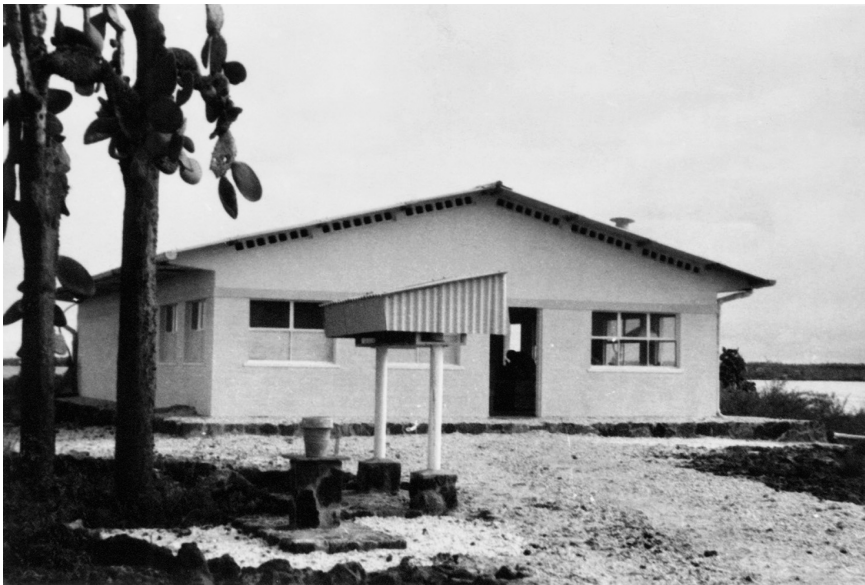
Fig. 2. — De voorgevel van het Charles Darwin Research Station in augustus 1962.
