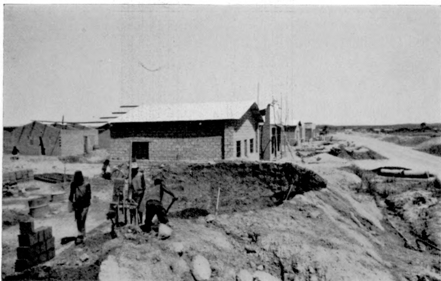
PHOTO 8. — Gros œuvre des maisons en briques adobes construites par les indigènes avec l'assistance du Centre.
