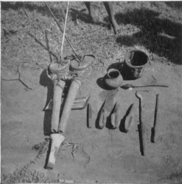
Photo 30. — SOUFFLET ET OUTILS DE FORGERON..
