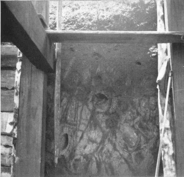
PHOTOGR. 4. — Formations superficielles de l'aplanissement P III, dans la région du Kibali ; de haut en bas : grenaille ferrugineuse cimentée, terre rouge, dolérite en voie d'altération. Dubele, mines de Moto.
