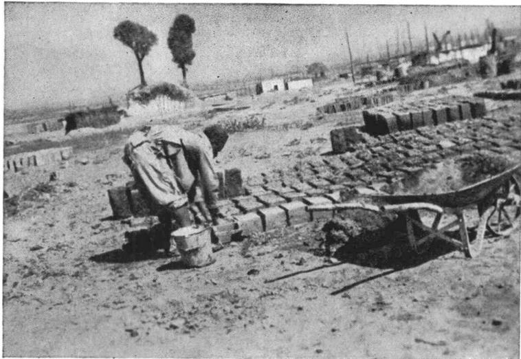
PH. 4. — La fabrication des briques adobes ou *de Kimberley*. La termitière visible à l'arrière plan fournit la terre argileuse.
