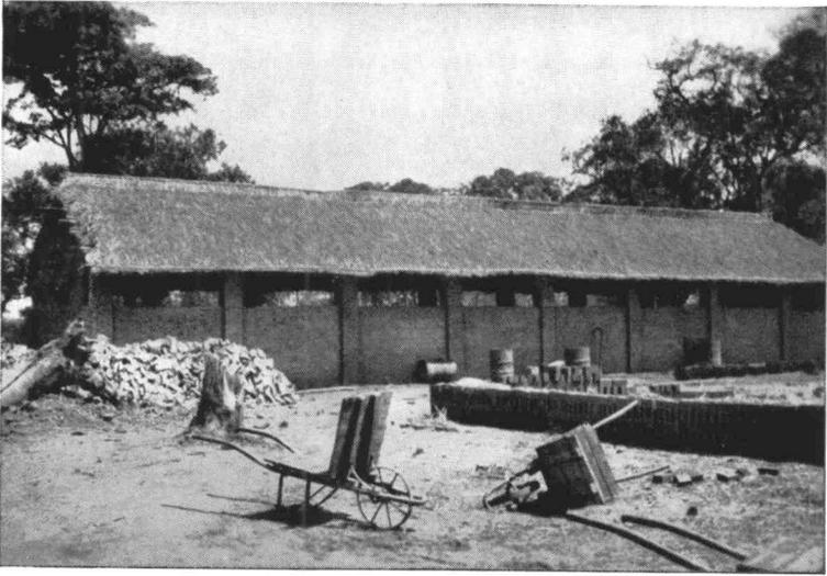
PH. 11. — Après avoir défriché l'aire où il répartira les divers bâtiments de son exploitation, le colon agricole fabrique souvent lui-même les briques nécessaires à la construction, ensuite il devient entrepreneur. Le toit de chaume a été adopté ici en raison de sa bonne protection thermique et surtout de son prix de revient. Les murs des étables et porcheries s'arrêtent toujours à une certaine distance de la toiture pour permettre une bonne aération.
