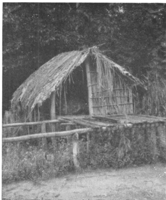
PHOTO 84. — Séchoir à coton zande (Territoire de Buta, chefferie de Nguru). Hangar précédé d'une claie destinée au séchage (voir figure 26).
