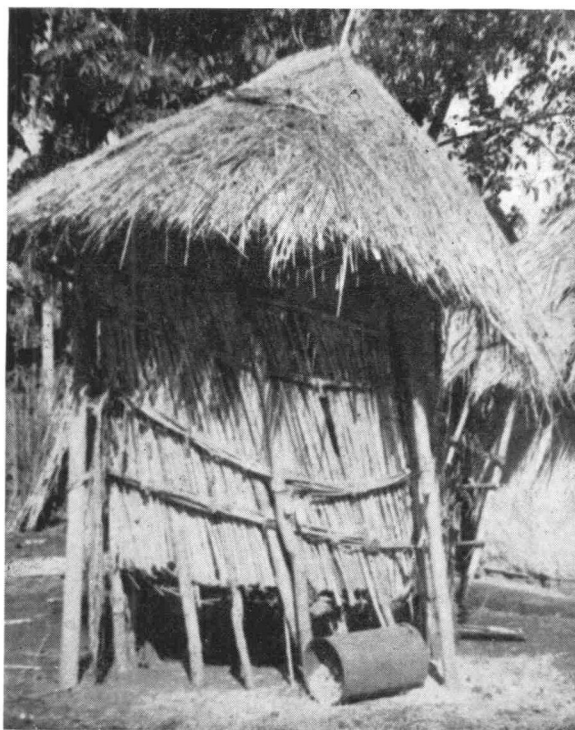
PHOTO 159. — Grenier bwisha (Territoire de Rutshuru, sous-chefferie Bukoma). Grenier cylindrique formé de tiges de papyrus. La hauteur totale est de 2,20 m.
