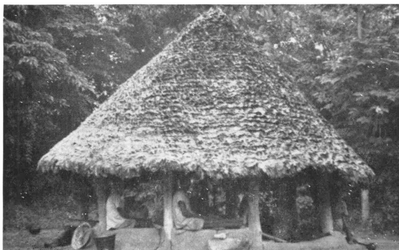
PHOTO 83. — Grenier — cuisine zande (Territoire de Buta, chefferie de Nguru). Construction E de la figure 26. Plan circulaire (voir aussi figure 30).
