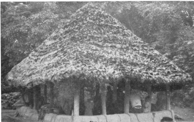
PHOTO 82. — Grenier — Cuisine zande (Territoire de Buta, chefferie de Nguru). Construction D de la figure 26. Plan rectangulaire (voir aussi figure 29).
