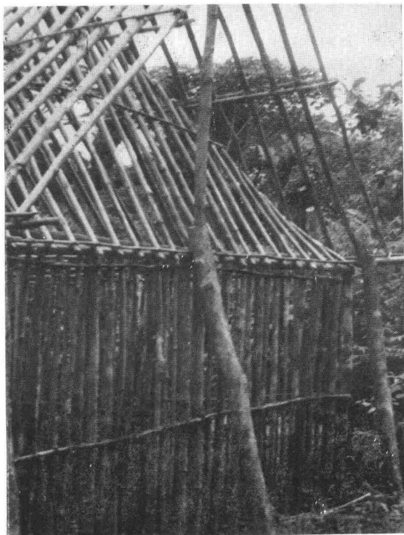
PHOTO 73. — Case en construction babua (Territoire de Banalia, secteur Babua de Kole, clan Botokwe, village Bonzangani). Case construite derrière le magasin J (voir figure 23). Remarquer la carcasse du toit : les petits cotés rentrent sous les grands.
