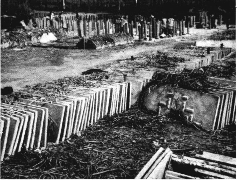
FIG. 15. — Stockage de dalles.
