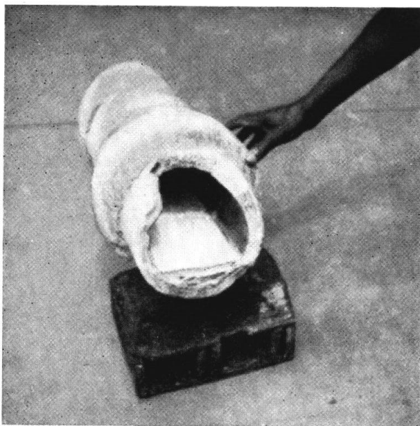
FIG. 5. — Altération d'un tuyau de béton.
