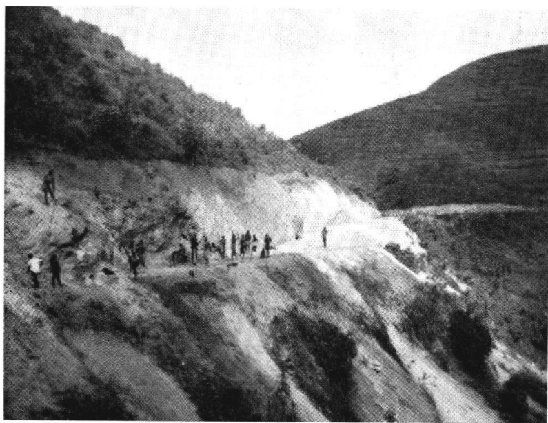
FIG. 6. — Etablissement à flanc de coteau d'une adduction.
