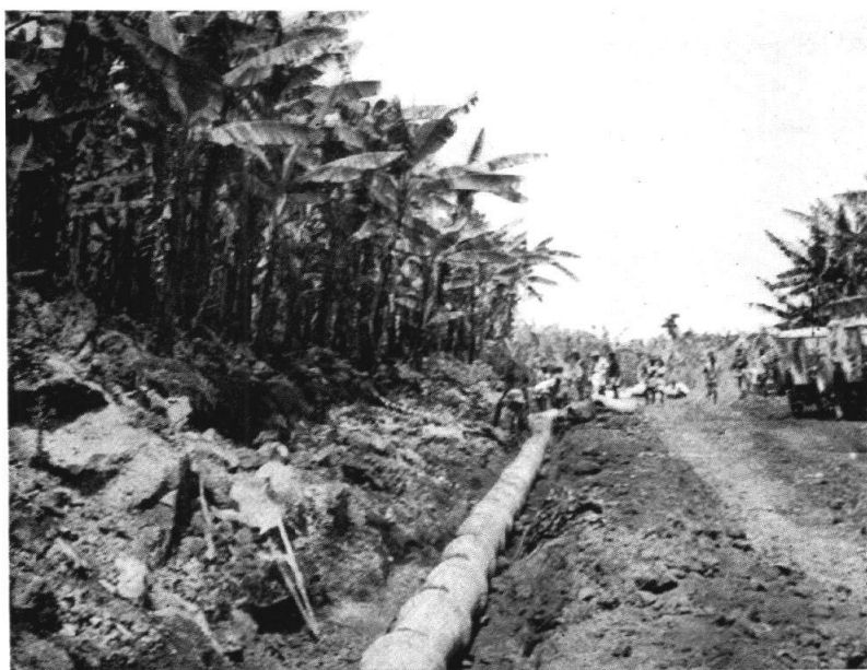
FIG. 8. — Pose de canalisations d'adduction.
