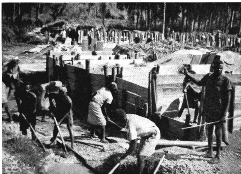
FIG. 13. — Lavage et stockage du sable pour fabrication de dalles pour les fontaines.
