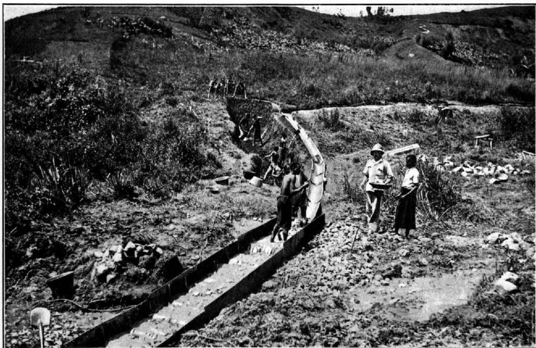
FIG. 31. — Type de « sluices » métalliques en activité. Alimentation par chenaux métalliques.
