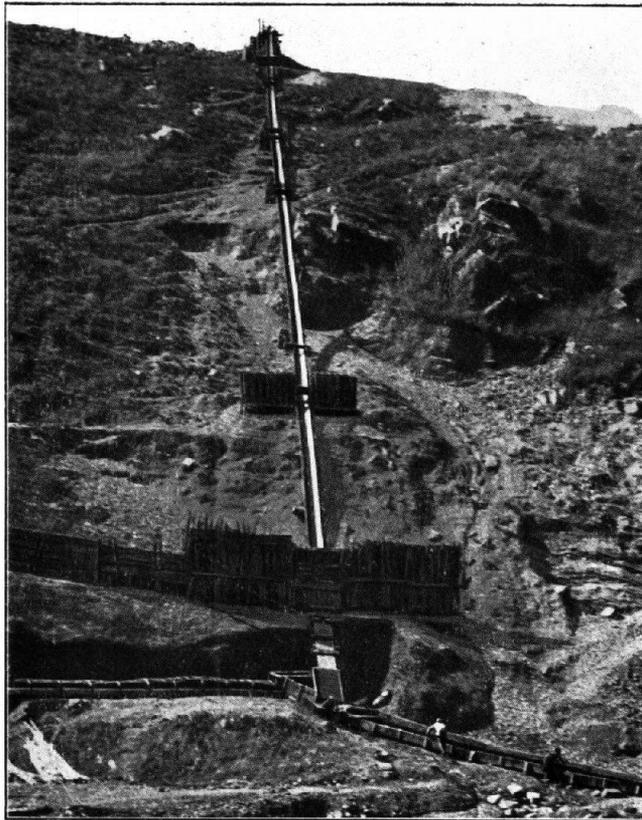
FIG. 25. — Transport du gravier par glissement.
