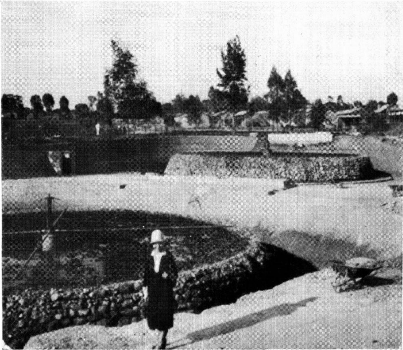
FIG. 10. — Les deux filtres bactériens en série de l'une des stations d'épuration d'Elisabethville (8 juillet 1933).
