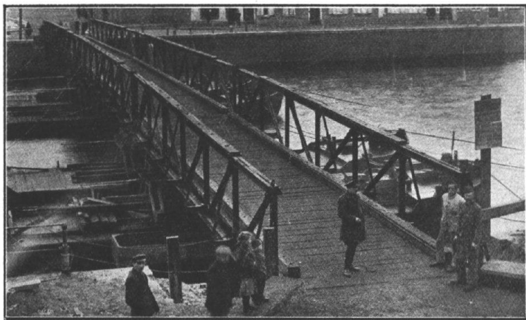
5. Pont de trois travées de 18, 24 et 27 m., sur pontons, avec pontière mobile, construit à Selzaete en 1918.
