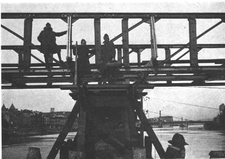
9. Même pont. Détails d'un appui intermédiaire provisoire avec châssis et étaçons de lancement.
