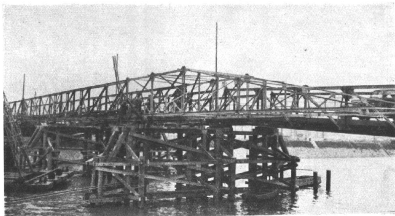
16. Même pont. Lancement de la deuxième file de trois travées après la mise en service de la première.
