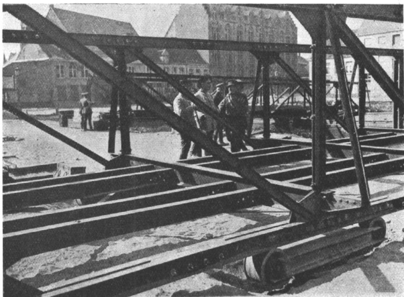
3. Détails de la charpente d'un pont et vue de son mode d'appui sur le châssis de lancement.
