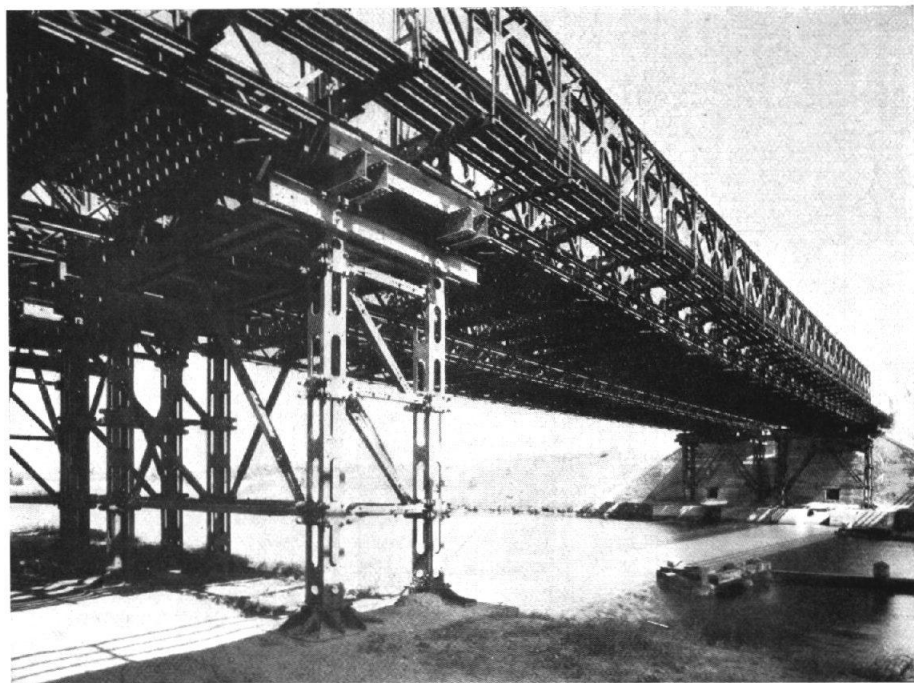
FIG. 21. — Les mêmes ponts vus de dessous. (Photo SERGYSELS.)
