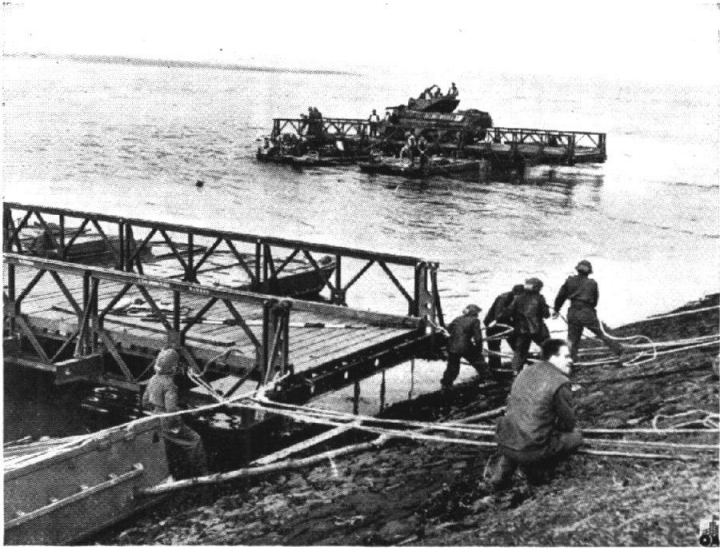
FIG. 27. — Bac de passage (train de navigation) en éléments Bailey.
