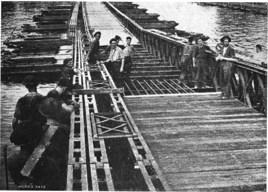
FIG. 26. — Pont Bailey sur supports flottants. (Cliché The Welder .)
