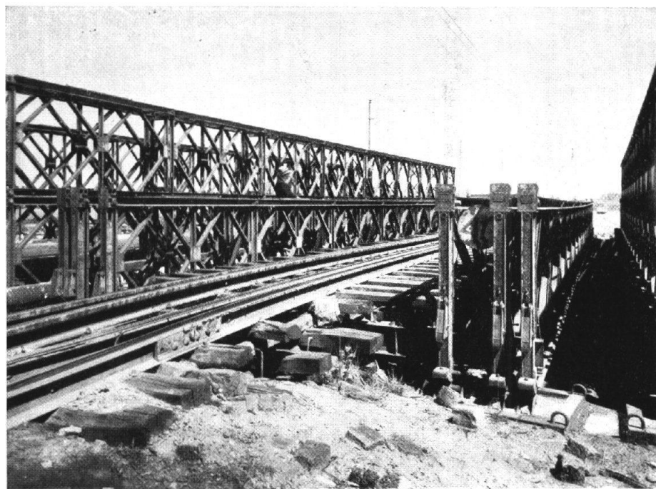
FIG. 16. — Pont Bailey à Anvers (Luchtbal) pour le passage du train électrique sur le canal Albert. — Remarquer la forme spéciale des montants d'extrémité en vue de répartir les sollicitations dues à l'effort tranchant. (Photo SERGYSELS.)
