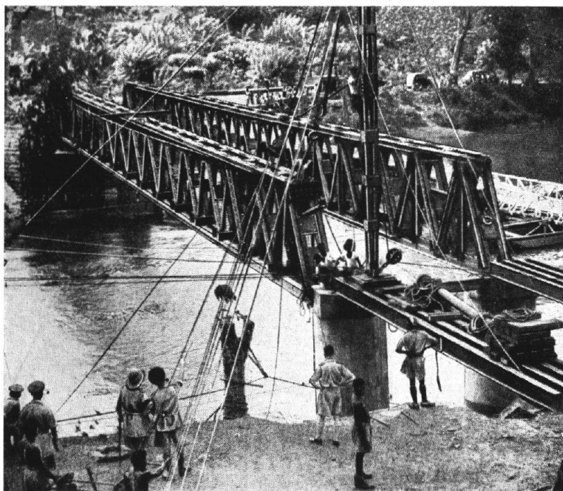
FIG. 12. Mise en place d'une travée Callender-Hamilton de 40 m de portée, à Ceylan.
