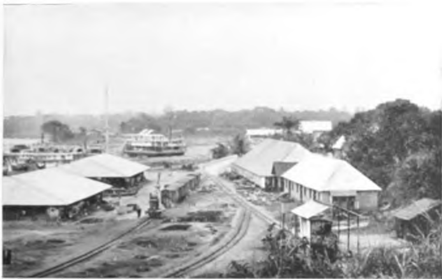
5. Le chantier en 1903. (Cliché Musée du Congo belge à Tervueren).
