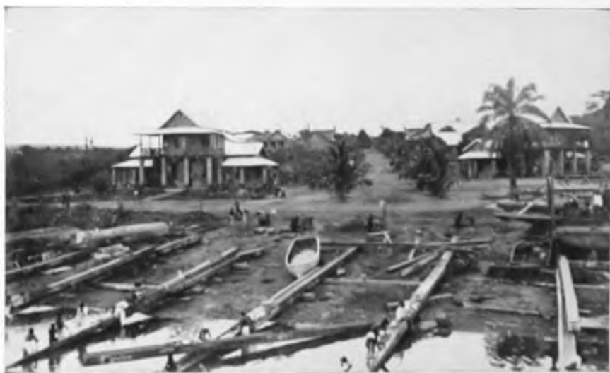
8. Chantier de montage et avenue du Roi Souverain (1905). (Cliché du Musée du Congo belge à Tervueren).
