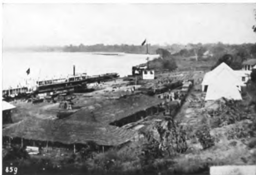
4. Le chantier en 1899. (Cliché Musée du Congo belge à Tervueren).
