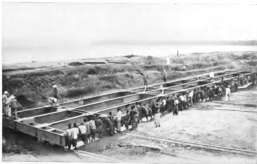
6. Essais du chariot du slip avant enlèvement du batardeau en 1904. (Cliché Musée du Congo belge à Tervueren).
