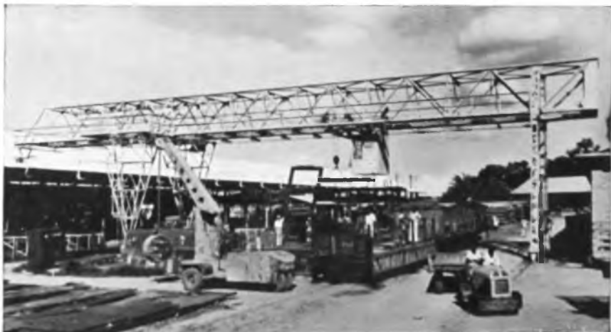
12. Pont portique desservant le parc à matériaux. (Cliché Maroldt).
