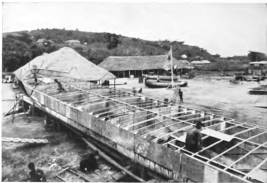
3. Le chantier en 1896 ; dans le fond, les habitations sur la Terrasse. (Cliché Musée du Congo belge à Tervueren).
