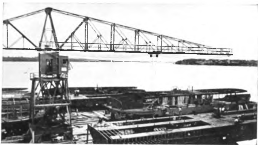
13. Grue du chantier de construction. (Cliché Maroldt).
