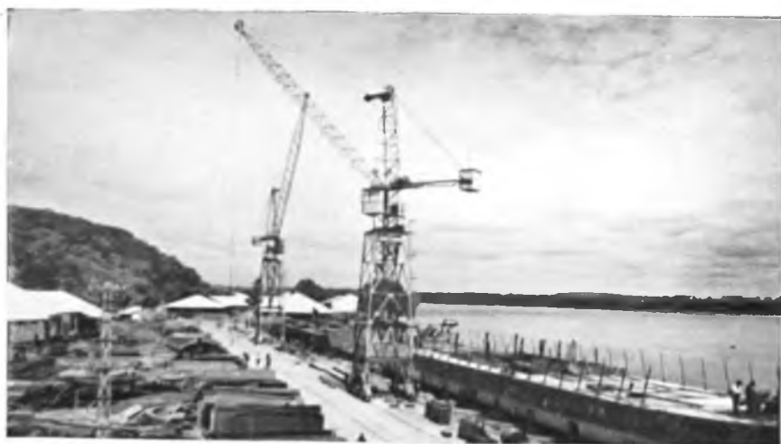
14. Grues du chantier de remontage. (Cliché Chanic).
