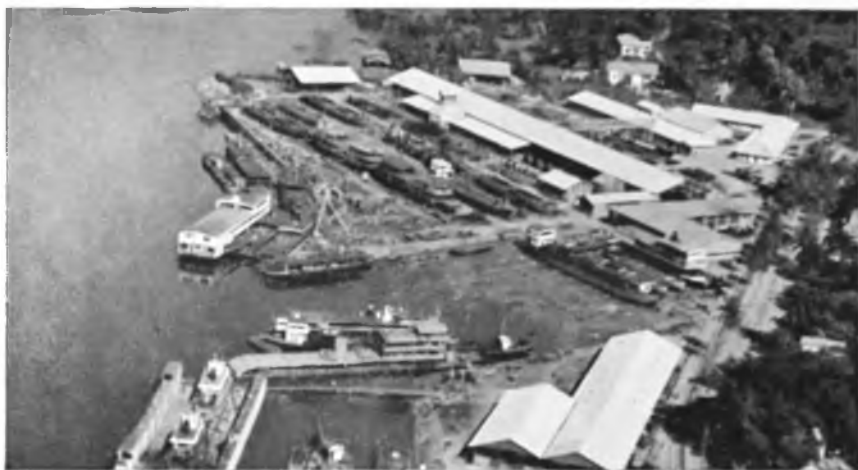
11. Chantiers de construction et de réparation. (Cliché Chanic).
