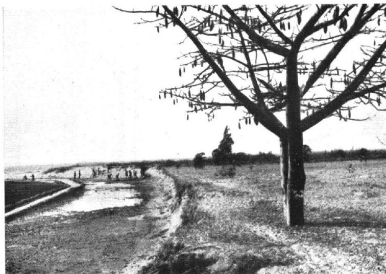
PHOTO 4. — Albertville. L'embouchure de la rivière Kalemie dans laquelle une cuvette a été creusée pour faciliter l'écoulement des eaux en saison sèche. 7 septembre 1947.
