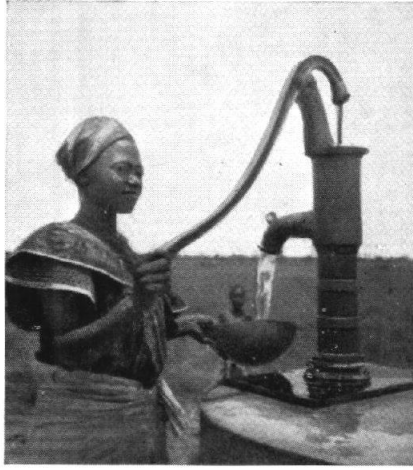
9. — Pompe montée sur puits aménagé.
