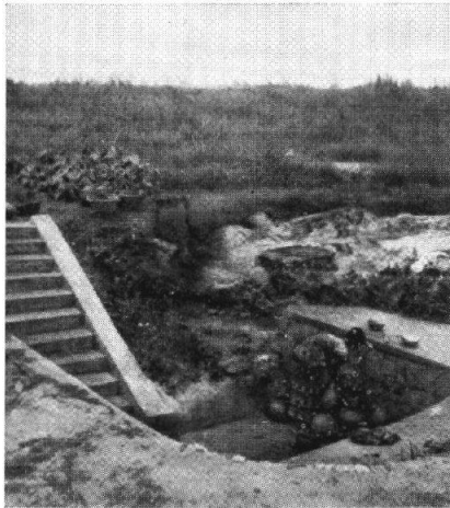
2. — APRÈS... Le même point d'eau après aménagement en fontaine.
