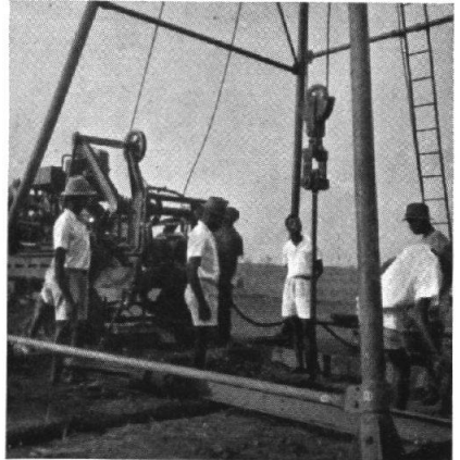
5. — Forage pour recherche d'eau (Bena Mande).
