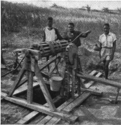
4. — Creusement d'un puits aux environs de Gandajika.
