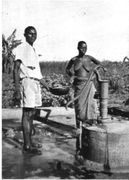
10. — Pompe installée sur puits (Terr. Bakwanga).
