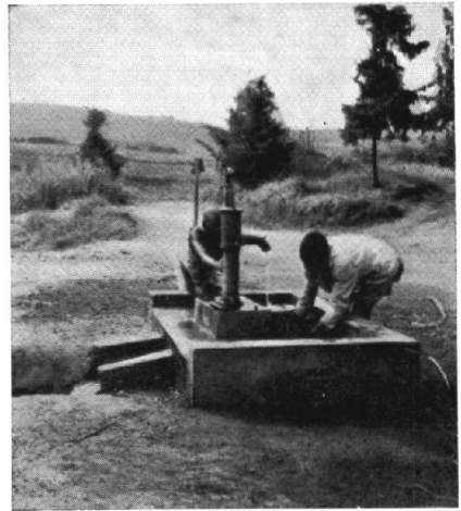
6. — Pompe installée au bord de la route de Kirundo (Terr. Muhinga).
