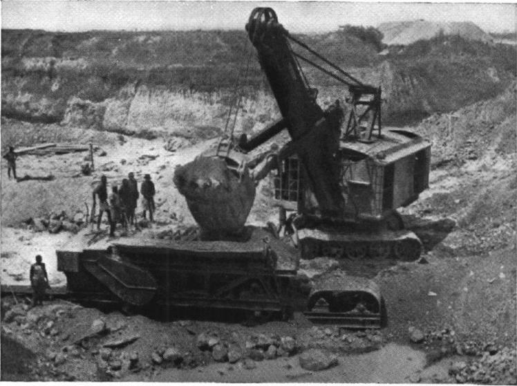
FIG. 4. — Chargement d'une trémie distributrice par pelle excavatrice.
