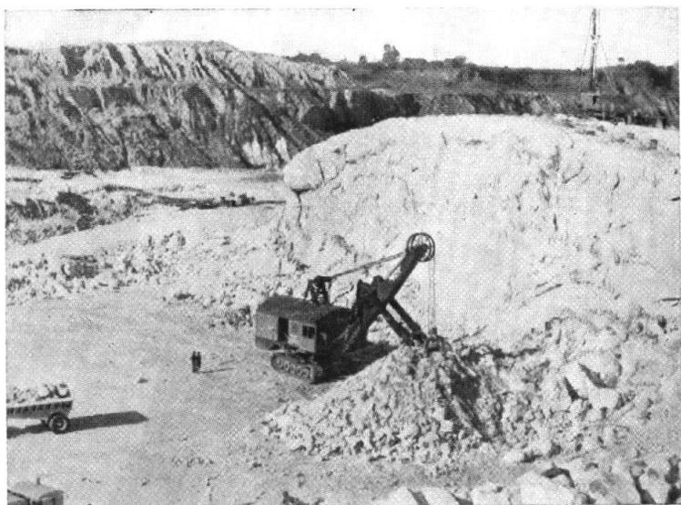
FIG. 10. — Chargement, par pelle 170 B, d'éboulis rassemblés par buldozers.
