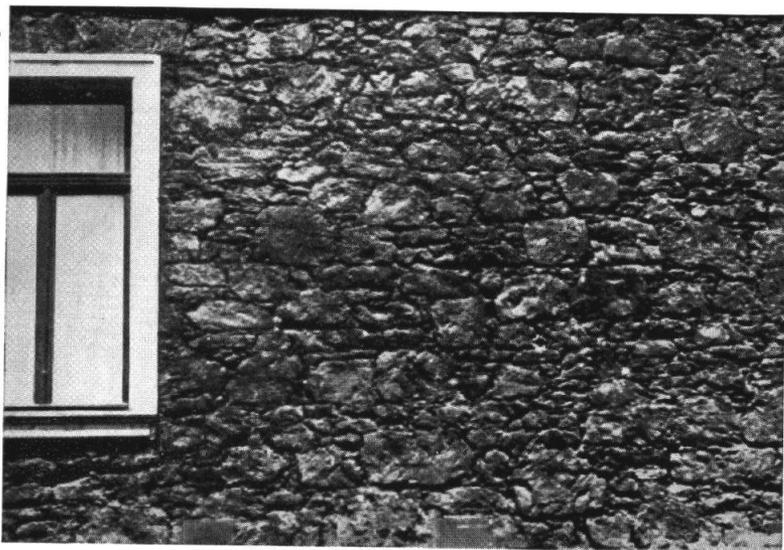
Photo 33. — Moellons maçonnés. Vue partielle.
