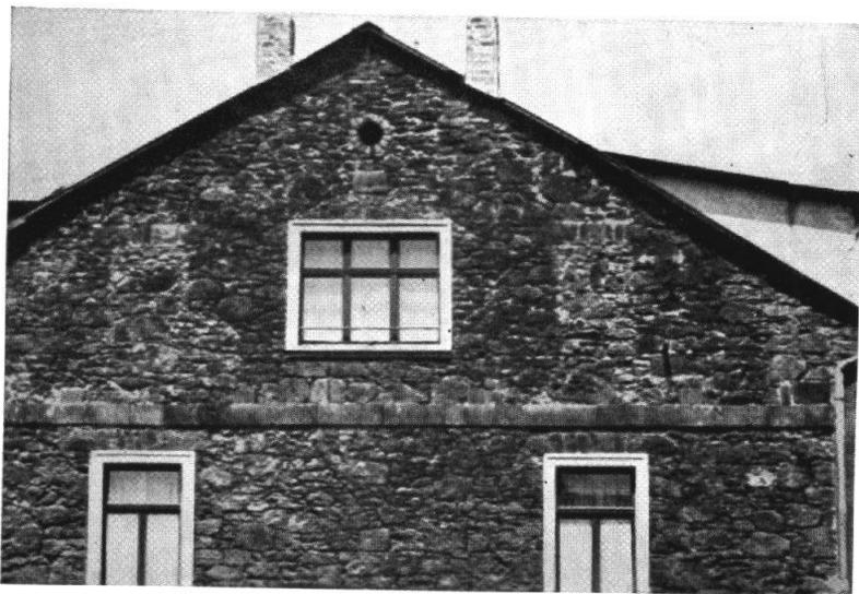
Photo 34. — Moellons maçonnés. Vue d'ensemble.
