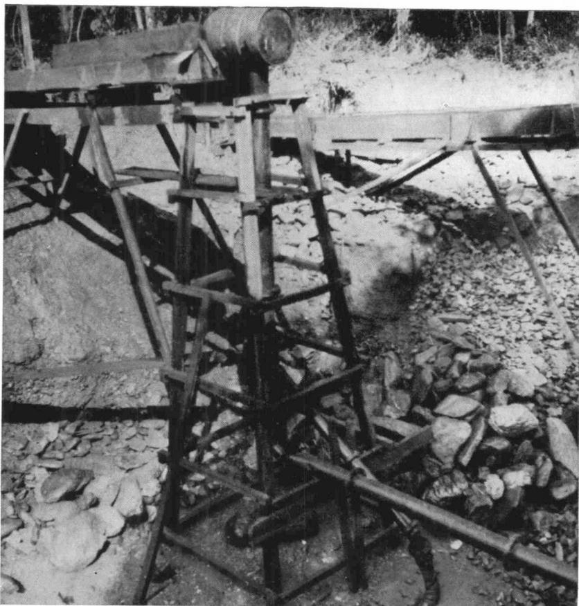
PHOTO 11. — Exploitation par élévateur hydraulique de fabrication locale dans le *flat* de la rivière Lulanga en 1951.
