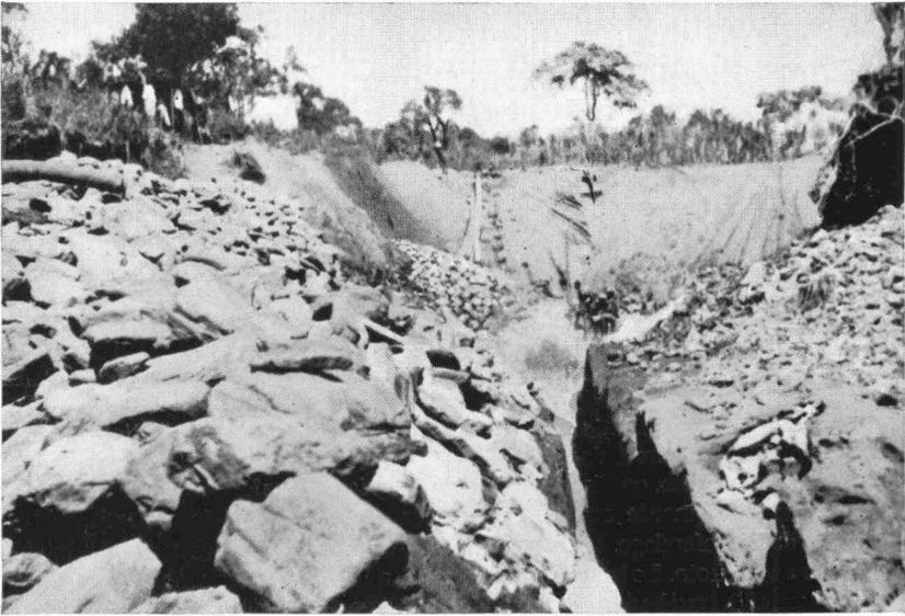
PHOTO 10. — Exploitation par *hydraulic mining* dans une terrasse de l'affluent Marengo proche de son embouchure dans la Kyimbi. On remarque la grande dimension du gravier et la rigole creusée à travers un bourrelet du *bed-rock*.
