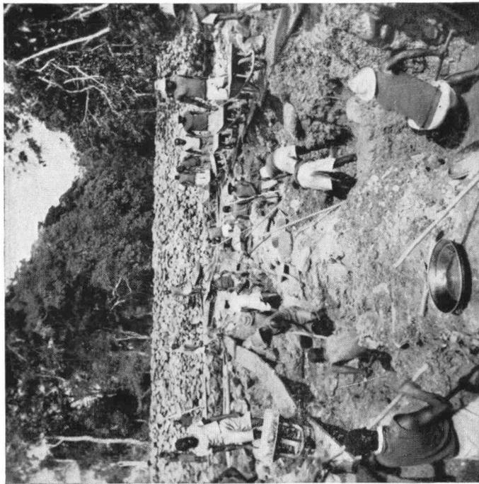
PHOTO 1. — Extraction du gravier du lit de la Kyimbi à l'abri du batardeau qu'on voit à l'arrière-plan.
