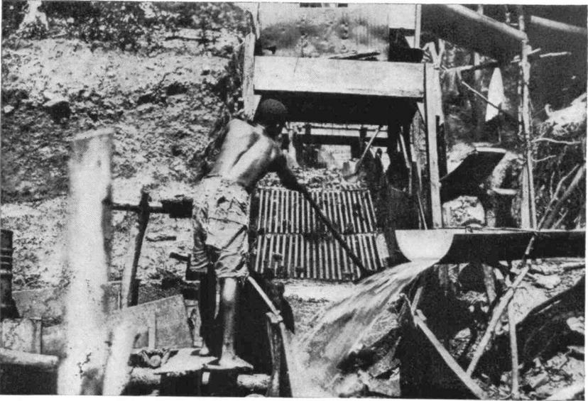
PHOTO 3. — Exploitation d'essai en terrasse par *sluice* de grande capacité. Le gravier est déversé sur un *grizzly* et arrosé copieusement.
