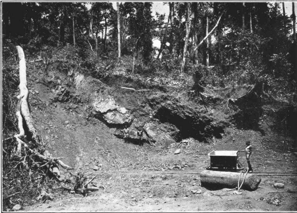
PHOTO N° 1. — Filon du massif C. Nord de la mine de Kanga (Kilo, mars 1933). Masse quartzeuse intrusive dans les schistes phylladeux, visibles au toit et au mur du filon (puissance : 2 mètres).
