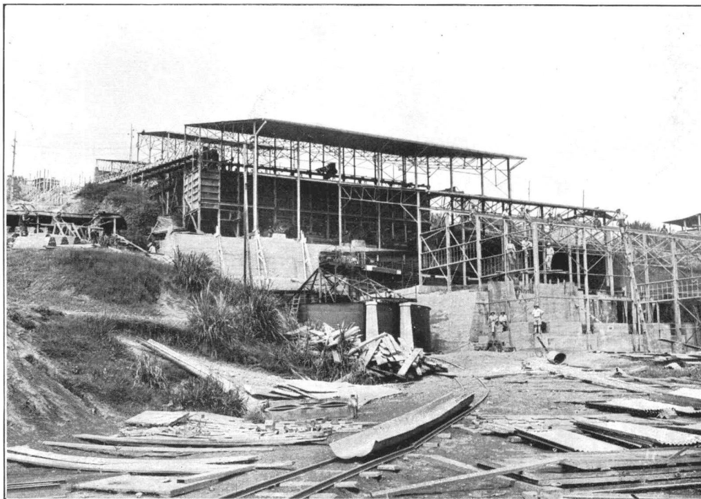
PHOTO N° 18. — Usine de concentration du Nizi (Kilo) en montage, en juillet 1931. Vue montrant l'atelier des tubes mills dont les trois unités sont déjà installées. En contre-bas la charpente de l'atelier de flottation en montage, à gauche duquel on voit le Dorr Thickener.
