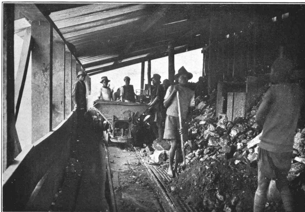
PHOTO N° 5. — Arrivage du minéral tout-venant à la partie supérieure de la trémie I du schéma (croquis n° 16).
