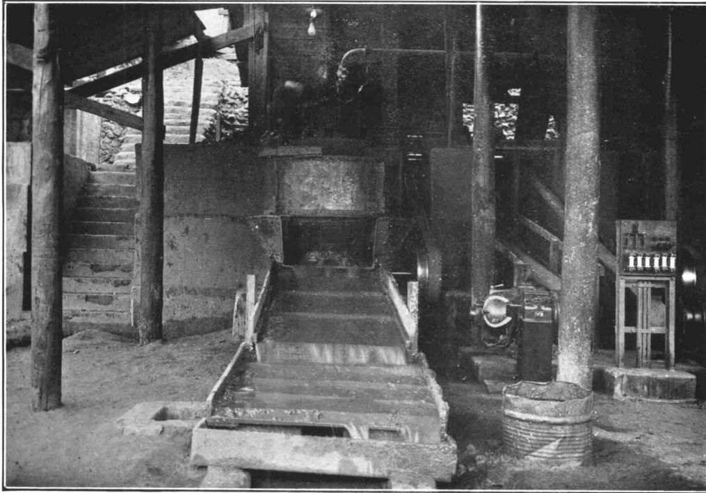
PHOTO n° 15. — Moulin chilien et sa première table amalgamée, ainsi que le premier appareil de récupération. Cette vue montre une table installée à contre-pente, donc mal réglée, ce qui diminue la surface utile active de la table et de la récupération.
