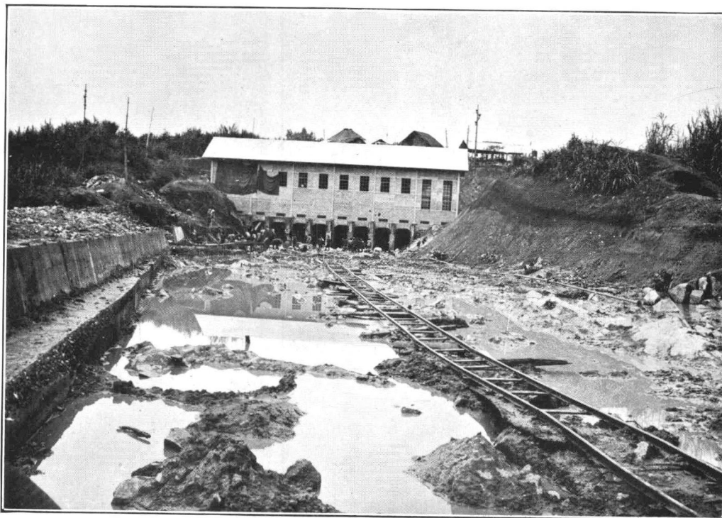
PHOTO n° 11. — Le canal de fuite de la centrale n° 2 de Kilo-Soléniamama au moment où les travaux touchent à leur fin.
