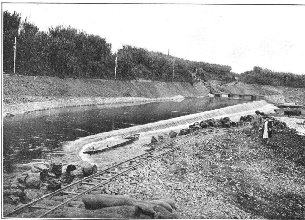
PHOTO n° 8. — Le canal d'amenée et le déversoir de la centrale hydro-électrique n° 2 de Kilo-Soléniamma installée sur la rivière Shari. (Fin des travaux.)
