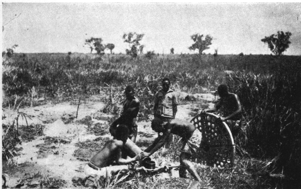
FIG. 17. — Photo 3. Vissage d'un tube sur le tubage d'une sonde Banka.
