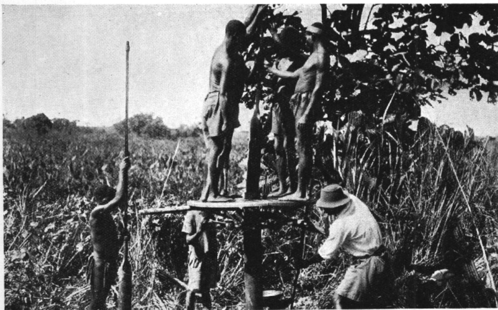
FIG. 20. — Photo 6. Extraction de la pompe remplie de gravier (à gauche la pompe de rechange prête à la descente).
