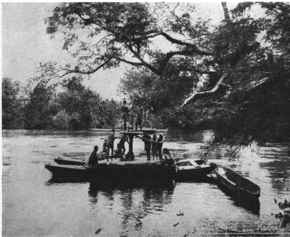
FIG. 15. — Photo 1. Sonde Banka installée sur un ponton reposant sur des baleinières métalliques attachées à un câble en acier tendu à travers la rivière Kibali (mine de Moto).
