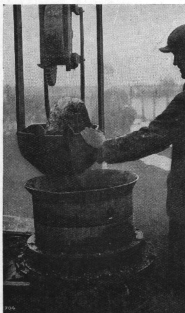
FIG. 33. — Benne remontant un galet de gravier qui a été isolé du terrain par la pénétration des tubes.
