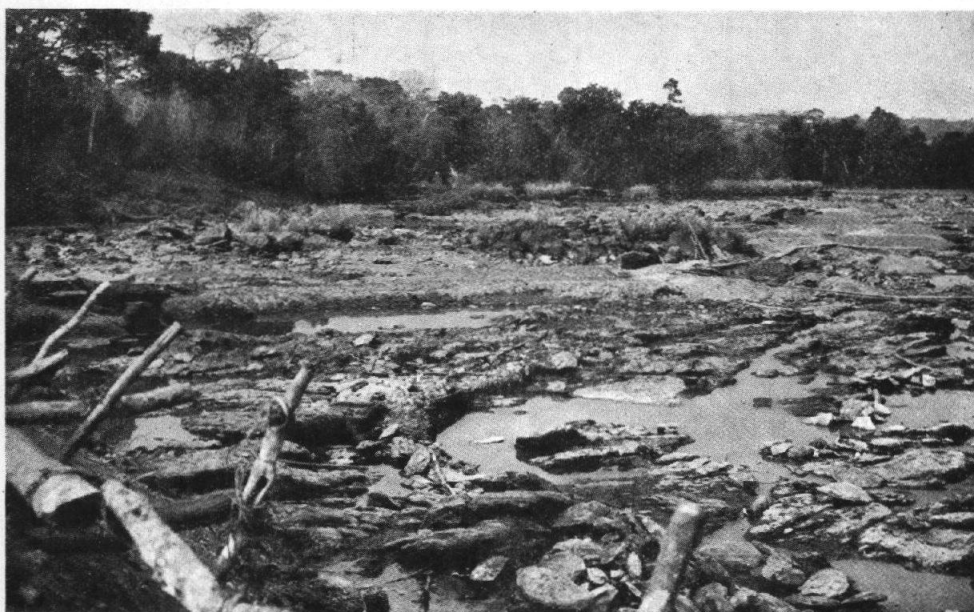
FIG. 57. — Photo 9. Bed-rock du Kibali mis à nu dans une cellule d'exploitation isolée par batardeaux.
