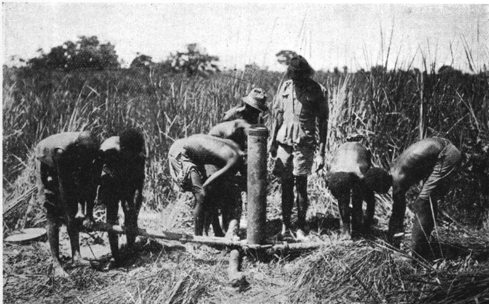
FIG. 27. — Photo 8. Extraction des tubes Banka après fin de sondage (exemple de mauvaise utilisation de la manivelle clef).
