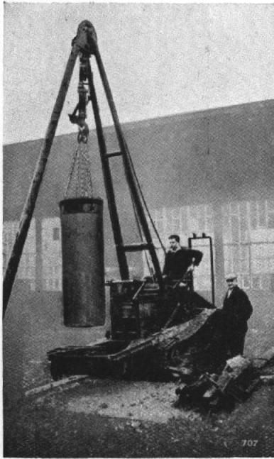
FIG. 37. — Le sondeur au travail remonte des tubes après fin de sondage.
