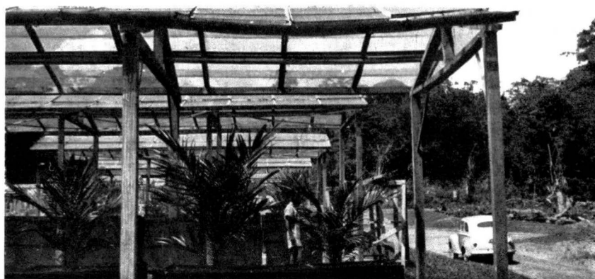
Vues générales des installations.
