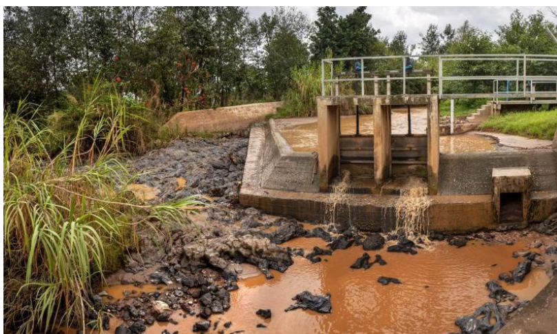
Fig. 1. — Exemple de petite centrale hydroélectrique au Rwanda (© Shutterstock).
