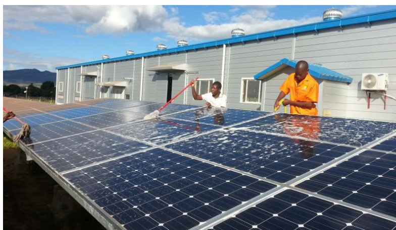
Fig. 2. — Panneaux solaires au Mozambique (© BTC/Dieter Telemans).
