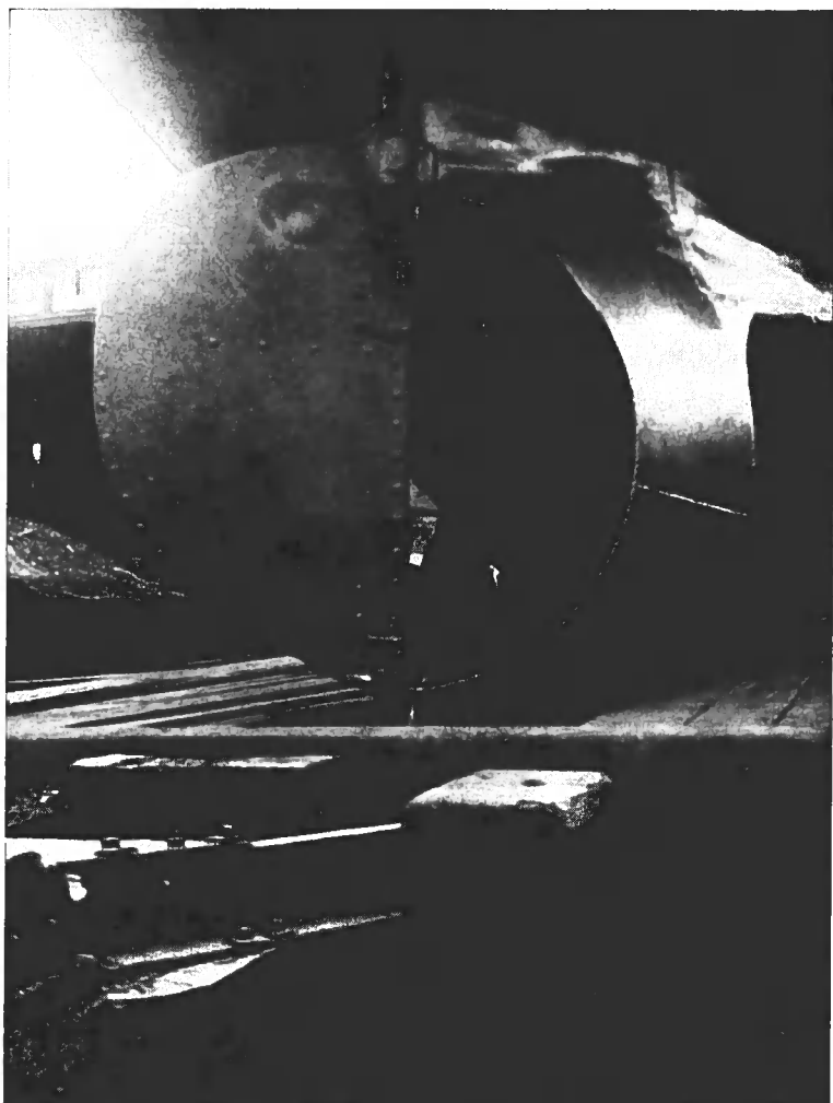
FIG. 55. — Arrière de bateau avec tuyère Kort.
