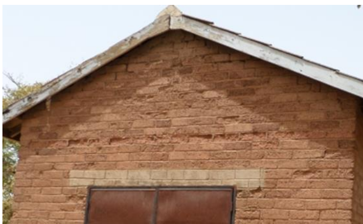
Figure 6. Érosion des murs en BTC non stabilisées exposées à la pluie, Ouagadougou, Burkina Faso (d'après O. Zoungrana, 2017)
